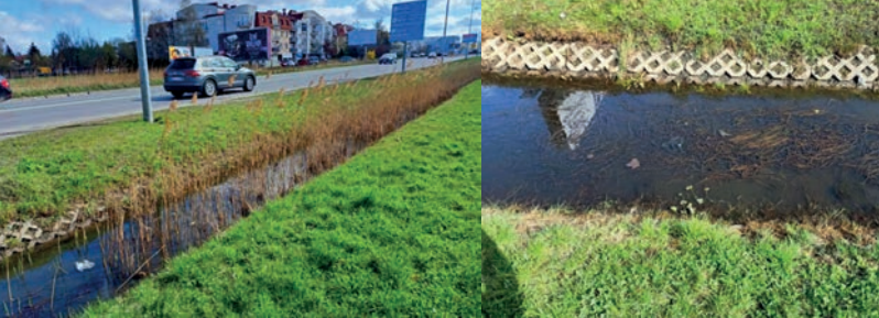
11 Відведення надлишків води з автодоріг за допомогою зелених конструкцій. Варшава, Польща (авторське фото)
