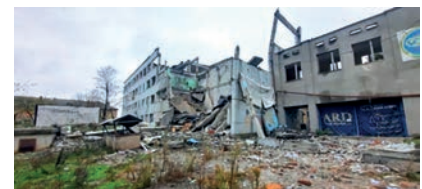
3 Зруйнований корпус Дружковського житлово-комунального фахового коледжу ДонНАБА (Краматорськ), який був відремонтований за кошти ЄС у 2021 р. (авторське фото)
