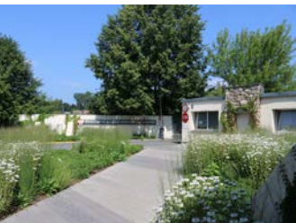
Вхідний вузол, після переробок 2014 року. Entrance node, after modifications in 2014.
